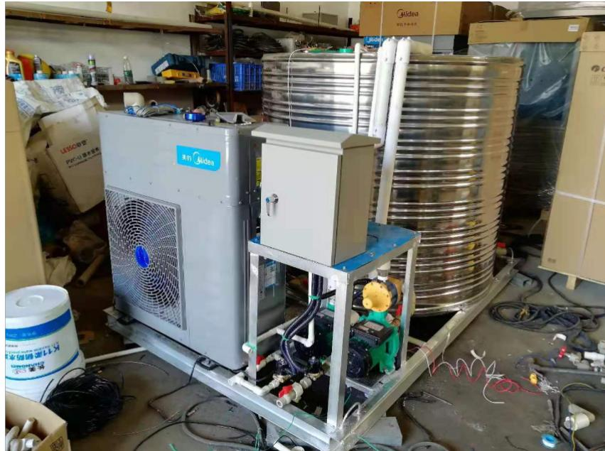
安全性高热水器的应用担心的莫过于安全性，电热水器漏电、燃气热水器漏气都会产生严重的危害，尤其是没有及时维护保养的热水器，一旦出现事故就会带来巨大的灾难。然而空气能一体机在安全性上更高级，通过介质换热，采用水电分离技术，避免电加热元件直接与水接触，杜绝了触电的风险。另外，空气能水泵主机内所使用的冷媒也不会进入室内，哪怕出现漏氟也不会危及室内人员的健康。此外，空气能一体机直接通过电来转换热量，不会产生有害气体（如二氧化碳、一氧化碳等），也能避免燃气中毒的风险，没有明火也不会有损害的风险。环保性高空气能一体机所使用的冷媒都在热泵主机内部，质量合格的空气能做好了管道与压缩机的连接，基本不会出现冷媒渗漏的情况。在空气能加热的过程中，相比燃气热水器加热，不会有有害气体的排放，既不会破坏环境，也不会给人体造成身体伤害。舒适度高空气能一体机根据功率可以配置相应容量大小的水箱，例如150升的水箱，足够一家四口人24小时的热水需求，洗脸、洗澡以及厨房用水都能轻松搞定，不用担心水温不够和水量不够等问题。很多热泵主机还采用了喷气增焓技术，能够在-25℃的温度下提供稳定的热水，当然室外温度越高。
