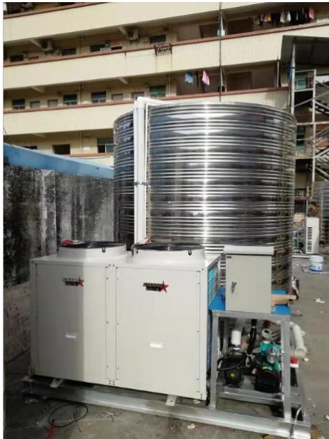
热水器也作为冬天必备的家用电器之一；同时节能现在也成为消费者选购家电时的一大参考指标。作为热水器领域节能新贵的“空气能热水器”，想必大家也略有耳闻。在不少厂商宣传中，“空气能热水器”号称一度电当四度用，节能效率高达75%。原理空气能热水器是利用少量的电来驱动压缩机工作，把空气中的热量转移到水中，使水变热，达到可以沐浴的水温。冷气热水器是一种能够提供全家恒温热水，同时还能不收费给厨房提供冷气的多功能空气能热水器。机器工作时，在风机的吸力作用下，室外普通空气从进风口进入顶部内腔，流过换热器，此时空气中的能量被换热器吸收，并转移到保温水箱中，给水加热；失去能量的空气温度降低，变成冷空气从风机吹出来，在夏天可用于厨房制冷。保温水箱中的热水可供全家沐浴，洗衣等多种用途。
